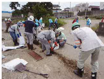
▲側溝の泥出し (H23.7.22)
