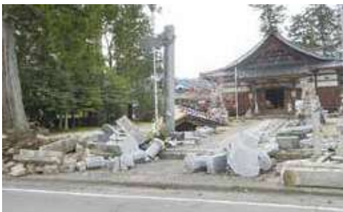
▲崩壊した鳥居と手水舎
